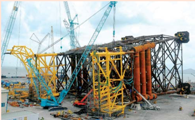
Chân đế giàn công nghệ trung tâm Hải Thạch có tổng trọng lượng chế tạo và lắp đặt lên đến 60.000 tấn. Ảnh: CTV
